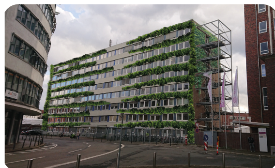
Abb.54 Mögliche Gestaltung von Fassaden durch Begrünung [Eigene Darstellung 2023]
