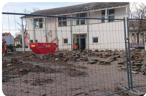
Abb.64 Freiflächen des Gemeinschaftshauses Pallaswiesenviertel Stand 15.03.2023 [Eigene Aufnahme]
