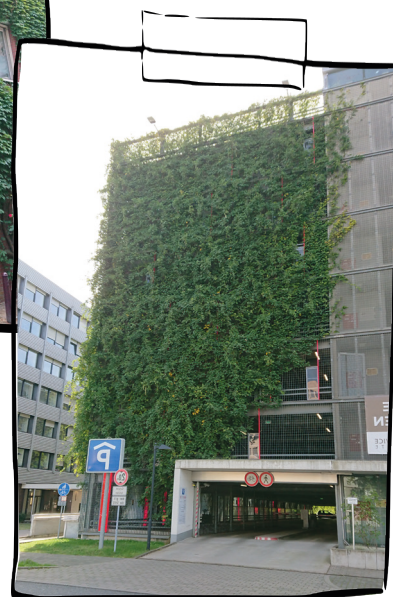
Abb.7 Bodengebundene Fassadenbegrünung an Parkhaus in Darmstadt (Eigene Aufnahme 2022)
