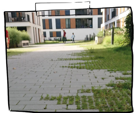
Abb.8 Teilversiegelte Wege in Darmstadt (Eigene Aufnahme 2022)
