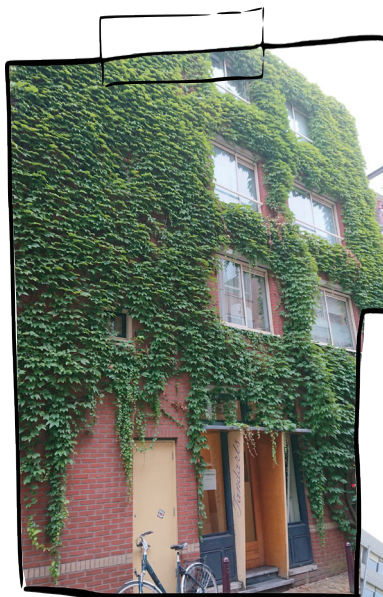
Abb.6 Bodengebundene Fassadenbegrünung in Amsterdam (Eigene Aufnahme 2022)
