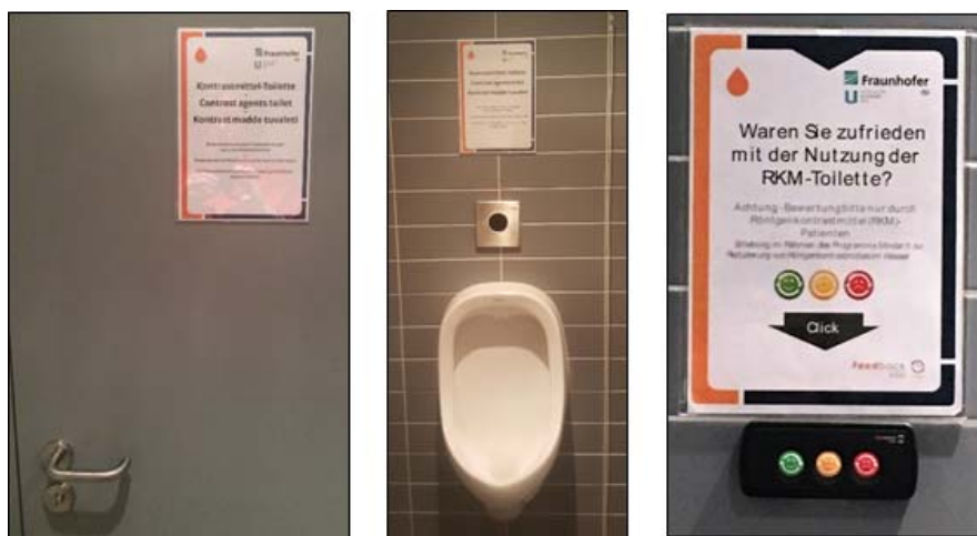
Abbildung 6-11: Tür mit Beschriftung auf der Damentoilette, Urinal mit Beschriftung auf Herrentoilette, Feedbacksystem im Waschbereich (von links nach rechts)
