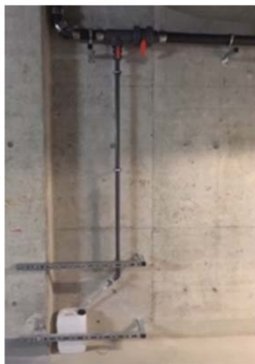
Abbildung 4-2: Eingebautes wasserloses Herrenurinal der Fa. Urimat und Installation zur Sammlung des Urins im Keller
