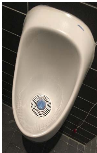
Abbildung 4-2: Eingebautes wasserloses Herrenurinal der Fa. Urimat und Installation zur Sammlung des Urins im Keller
